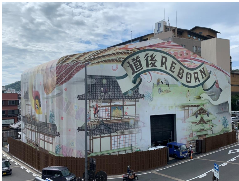
写真 2-1 道後温泉本館（撮影：桑名沙依、2020 年 7 月 29 日撮影）
