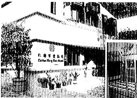
写真3 新設の紅磡明愛勸苑の外観と居室（上階はかなり洒落なマンションである）（表4の1b）
