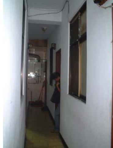
写真 34 アパートの内部
